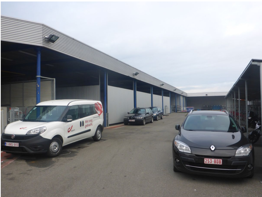
Figuur 53: foto vanop de inrit van de terreinen van bpost met aan weerszijden opslagruimtes
