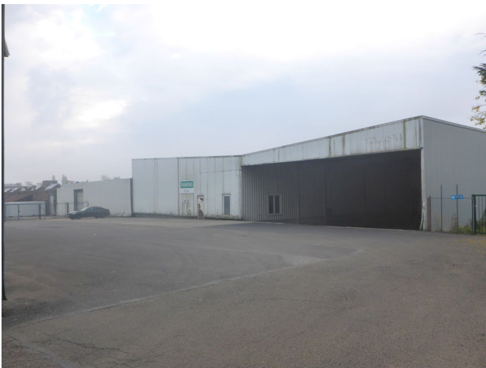
Figuur 49: foto vanuit noordwestelijke hoek van de leegstaande panden
