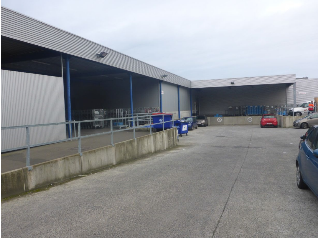
Figuur 54: foto van de inrit waarop duidelijk hoogteverschillen waarneembaar zijn
