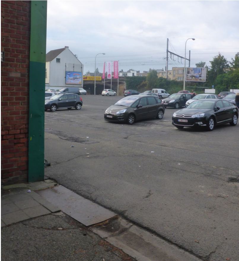
Figuur 42: foto vanuit de noordelijke zijkant van Smatch waarbij een afvoergoot zichtbaar is
