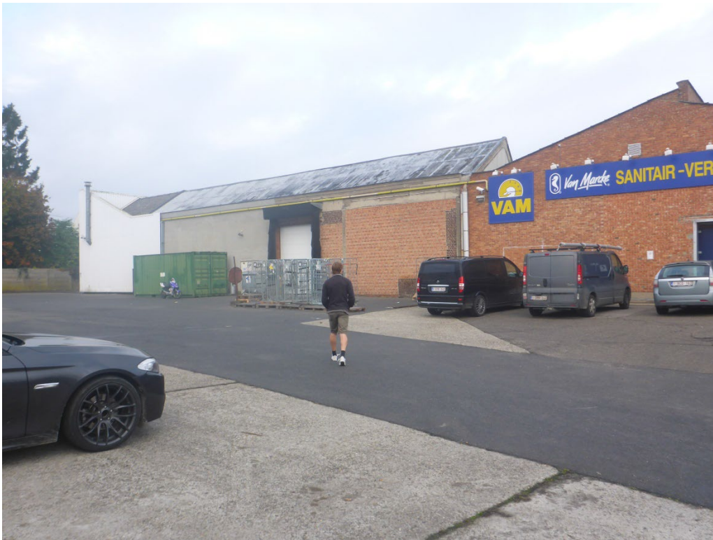
Figuur 45: foto van de zuidoostelijke hoek van het gebouwencomplex
